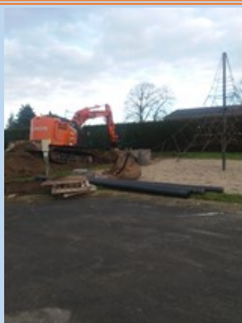
Début des travaux par l'entreprise de terrass- ement
