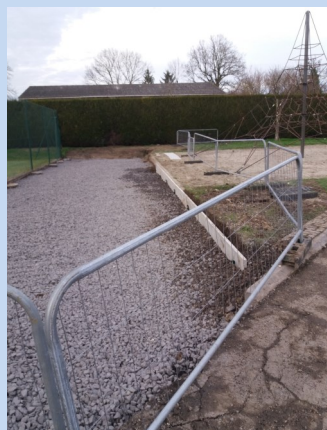
Mise en place des plaques de bordures pour éviter l'effon- drement du terrain pyracorde par nos soins.
