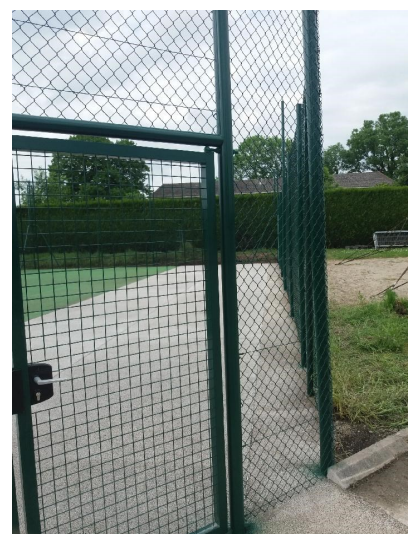
Pose du grillage
