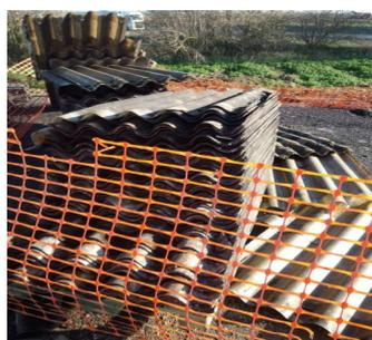
**Seule une entreprise spécialisée procède au filmage des plaques pour éviter la propagation des fibres d'amiante.**
