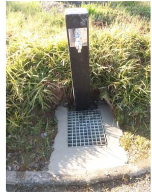
Réparation du point d'eau dans le haut du cimetière ; lors de la remise en eau du circuit une fuite est détectée à l'intérieur de la colonne. Comme tout le système est soudé, le remède a été de tout changer pour permettre définitivement l'accès au flexible interne. La grille est scellée à part. Les robinets ont été remplacés, plus de fuite d'eau !
